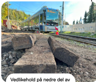
Vedlikehold på nedre del av Ekebergbanen
