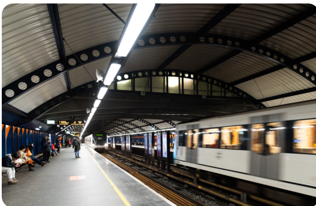
Stortinget T-banestasjon er en av flere stasjoner hvor gamle lysstoffrør er skiftet ut med LED-lys.
